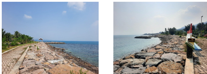
Gambar 4. Breakwater di Kecamatan Rajabasa
