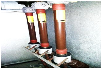
Gambar 12. Solefuse dalam melindungi trafo tegangan
